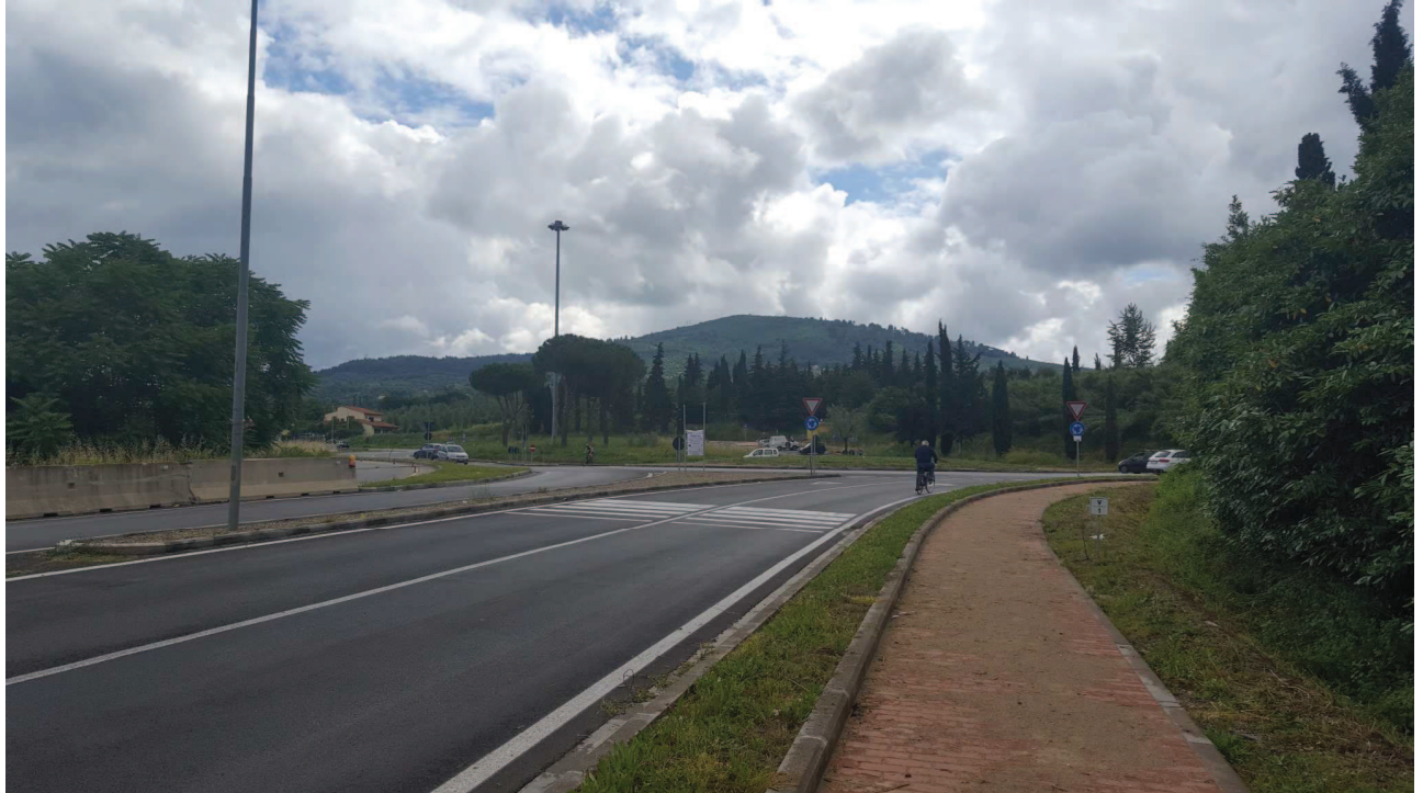
Foto panoramica dell'intersezione vista provenendo da Firenze
